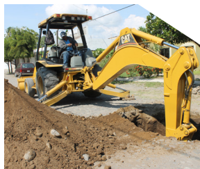
Rehabilitación de sistema de drenaje y alcantarillado
