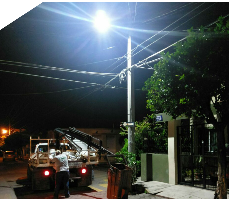
Personal del H. Ayuntamiento colocando luminarias en calle Hidalgo
