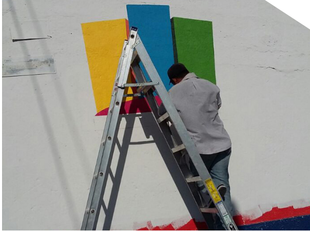
Personal de obras públicas pintando el rastro municipal
