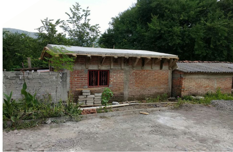
Construcción de techo firme en la comunidad de Pueblo Juárez.
