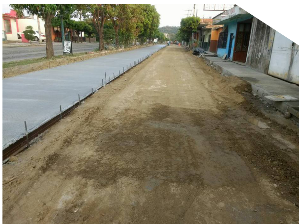
Pavimentación de concreto hidráulico en calle 12 de Octubre.
