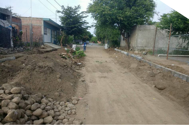
Construcción de empedrado en la colonia Jardines del Llano.
