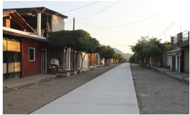
Pavimentación de concreto hidráulico en calle Constitución.
