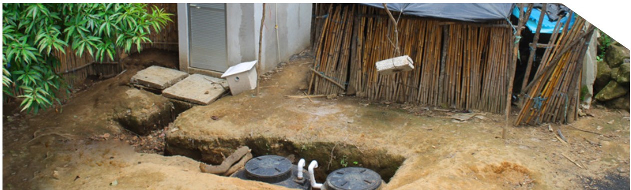
Colocación de baños con biodigestores en la comunidad de Cruz de Piedra.
