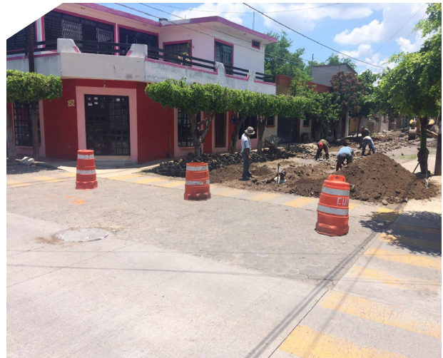
Empedrando la calle Manuel Álvarez en la cabecera municipal.
