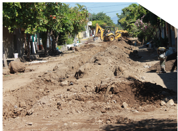
Sustitución de drenaje en colonia Jardines del Llano.
