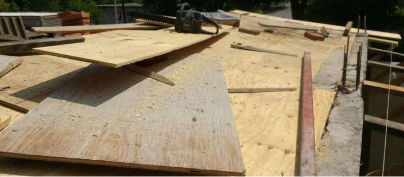
Cimbra para construcción de losa de concreto en Agua Zarca.
