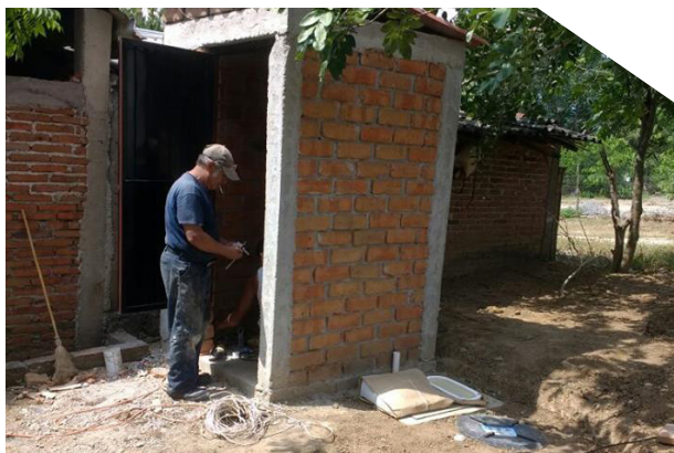
Albañiles construyendo los baños en comunidad de Cruz de Piedra.
