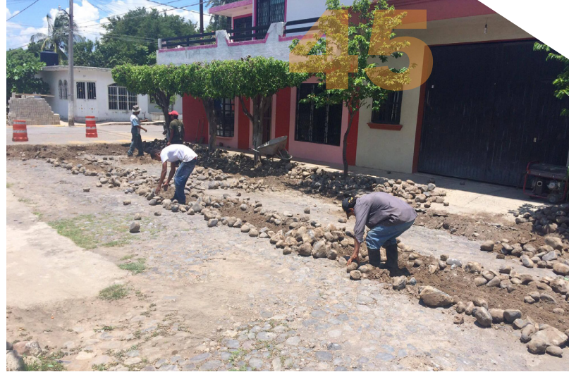
Trabajadores empedrando la calle Manuel Álvarez.
