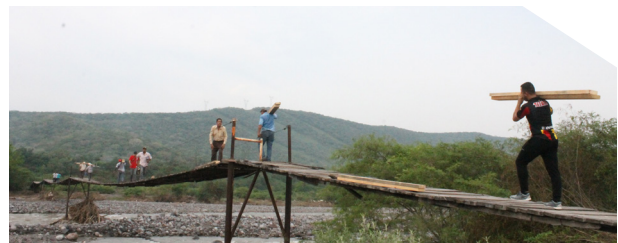
Rehabilitación de puente colgante de la comunidad de El Chical
